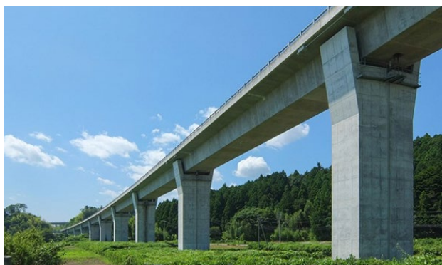
常磐道木戸川橋下部工工事
