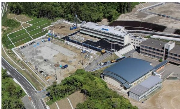
災害復興豊間中学新設工事
